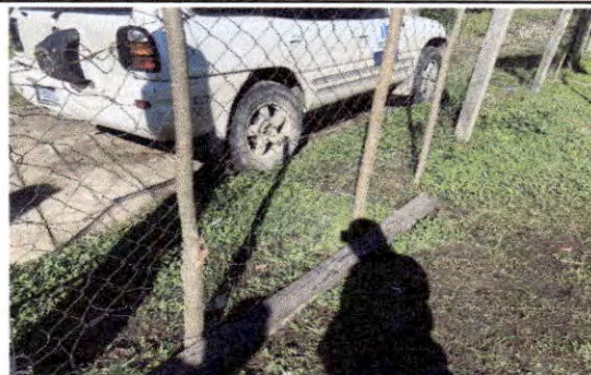
Foto 2: Malla en malas condiciones.
