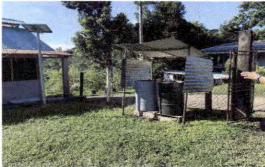
Foto 7: Vista frontal del cercado en malas condiciones.
